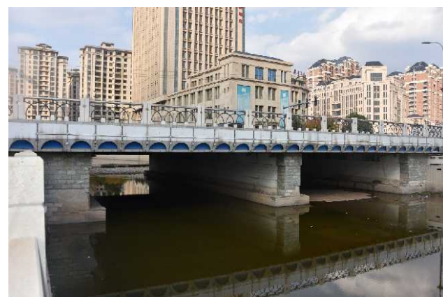
图 1.3 乌审街小桥侧面实景照
